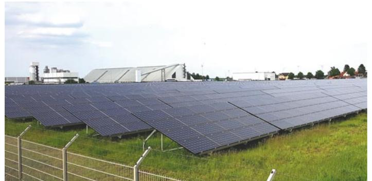
Mehr als 24.000 Solarmodule mit einer Leistung von insgesamt 5,8 Megawatt produzieren auf dem sechs Hektar großen Gelände rund 5,6 Millionen Kilowattstunden Strom im Jahr. Rein rechnerisch können damit rund 1.500 Drei-Personen-Haushalte mit Strom versorgt werden.
